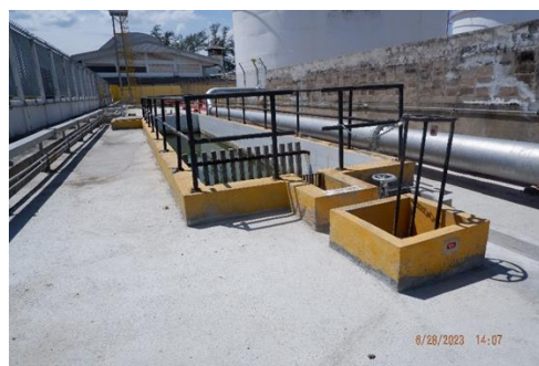
ภาพที่ 9 บ่อดักคราบน้ำมัน Oil interceptor เพื่อทำการแยกน้ำมันออกจากน้ำก่อนระบายสู่ลำรางสาธารณะ
