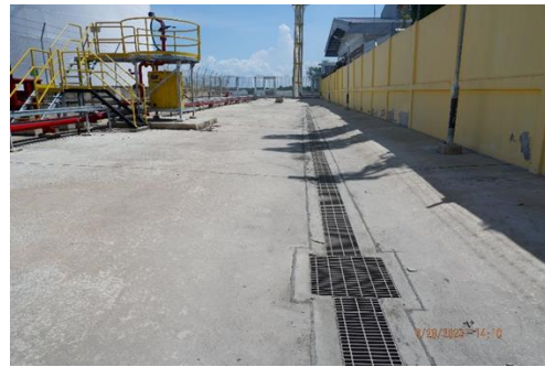
ภาพที่ 2 รางระบายน้ำคอนกรีตภายในคลัง
